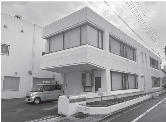
保安センタ建物外観
